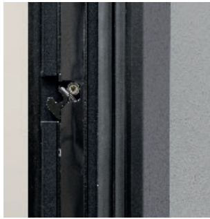
Der Verschluss mit pferdekopfförmiger Verriegelung im Rahmen
